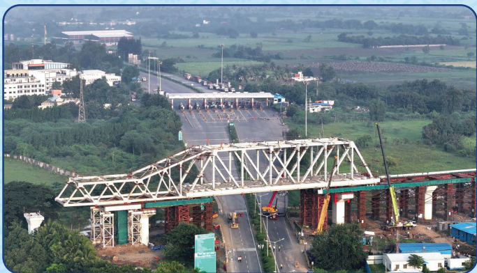
70 मीटर लंबा पहला स्टील पुल
