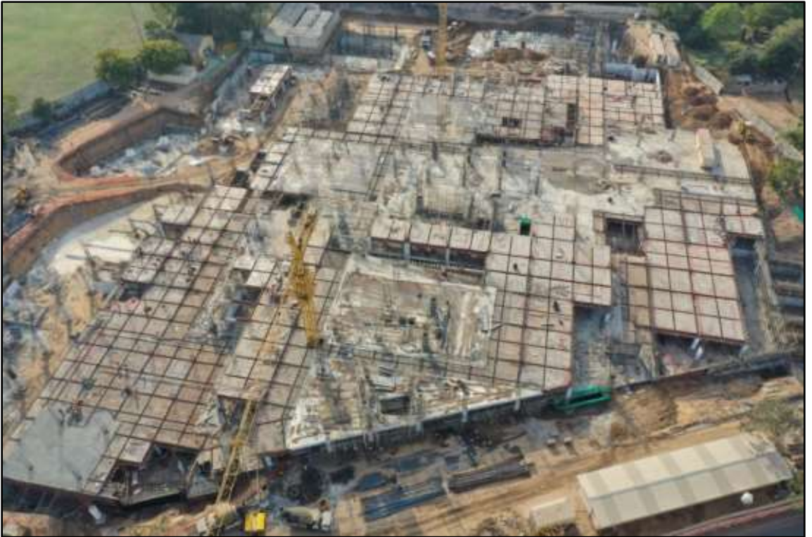
यात्री टर्मिनल हब, साबरमती, गुजरात में भू तल स्लैब का निर्माण कार्य प्रगति पर
