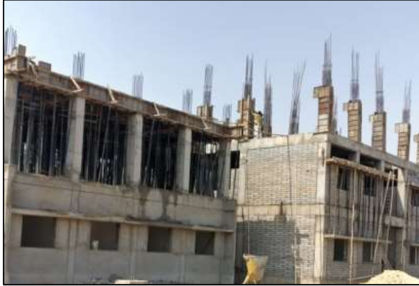
ब्रिज, वर्कशॉप, अहमदाबाद के प्रशासनिक भवन में स्लैब और स्तंभ, सुदृढीकरण और आरसीसी का कार्य प्रगति पर
