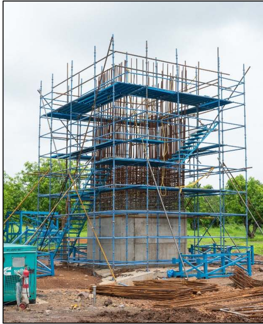
वलसाड, गुजरात में जारी पियर शटरिंग का कार्य।
