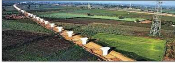
बुलेट ट्रेन के लिए गुजरात में बनाए जा रहे पुल के लिए खड़े किए पिलर।
