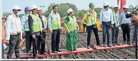
गर्डर की खासियत: 42 मीट्रिक टन स्टील व 390 घन मी. कंक्रीट लगेगा
