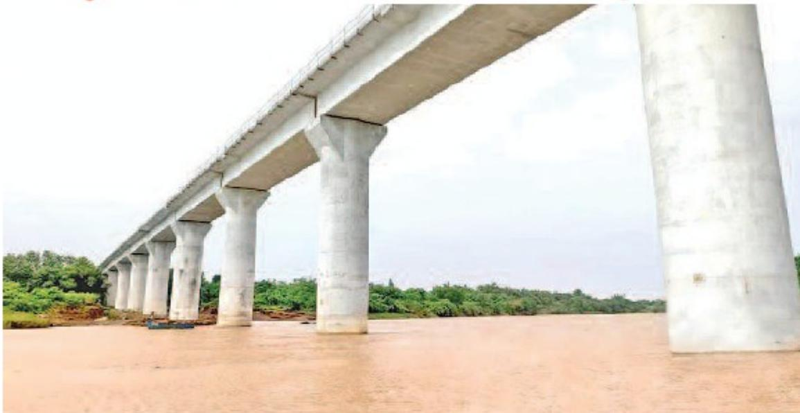
बुलेट प्रोजेक्ट को तैयार करने में लगी कंपनी एनएचएसआरसीएल ने औरंगा नदी पर पुल का निर्माण पूरा कर लिया है। यह एमएएचएसआर कॉरिडोर पर अब तक पूरा हुआ पांचवां नदी पुल है। कुल 320 मीटर लंबा यह पुल वापी और बिलिमोरा एचएसआर स्टेशन के बीच में है। बुलेट ट्रेन कॉरिडोर पर कुल 24 नदी पुल हैं, जिनमें से 20 गुजरात और 4 महाराष्ट्र में हैं।
