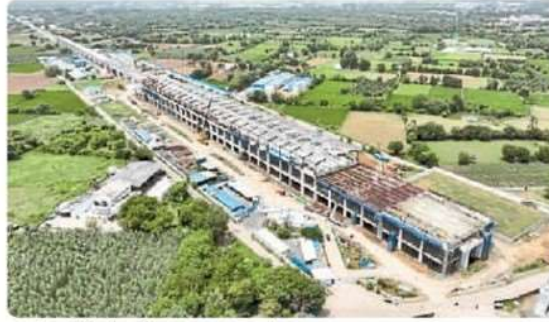
आणंद में निर्माणाधीन एचएसआर स्टेशन।
