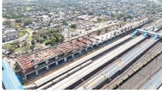
अहमदाबाद में निर्माणाधीन एचएसआर स्टेशन।
